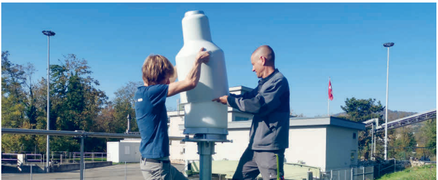
Gemeinsam geht's leichter: Die Regenmessstation wird montiert.
