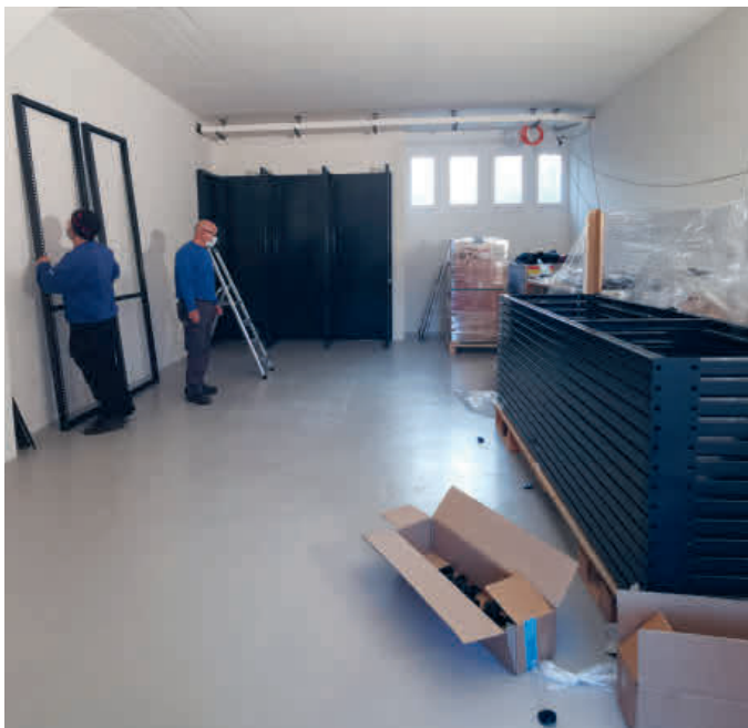
Das Material für die Lagergestelle wird angeliefert.
