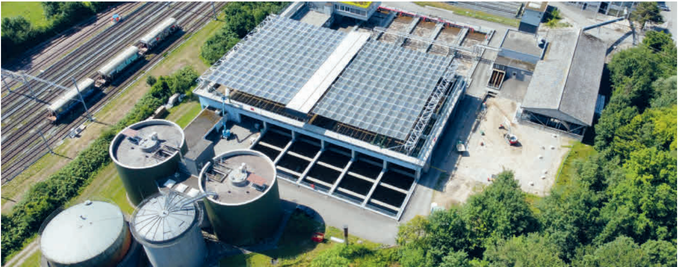
Das innovative Solarfaltdach überdeckt einen Teil der Klärbecken und hemmt so das Algenwachstum.
