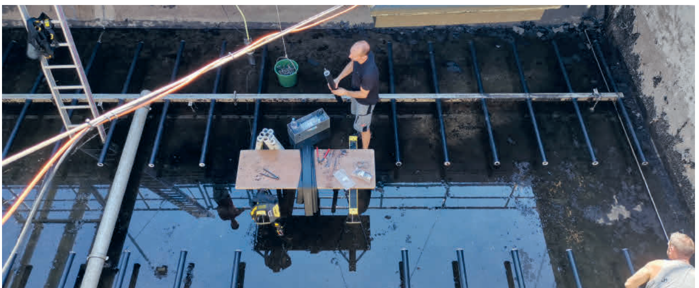
In aufwendiger Handarbeit werden 1080 neue Membranen aufgezogen und wieder montiert.
