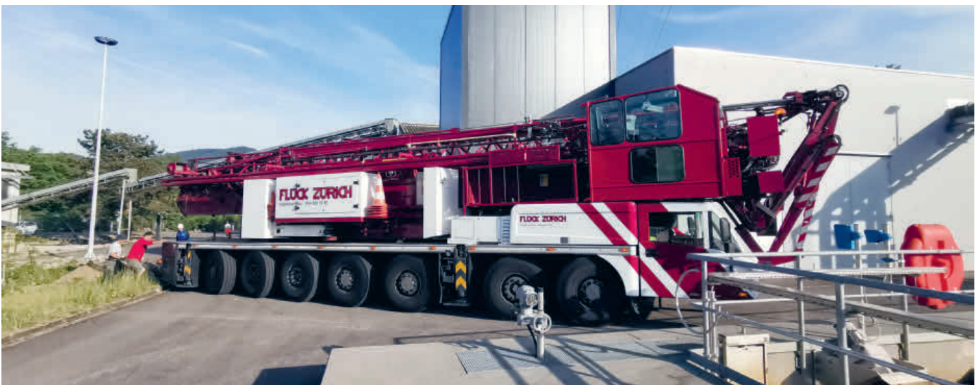
Für die Montage kommt ein riesiger Kranlastwagen zum Einsatz.
